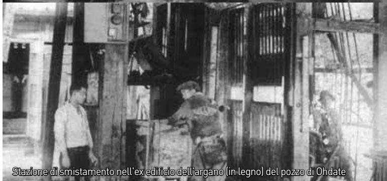
Stazione di smistamento nell'ex edificio dell'argano (in legno) del pozzo di Ohdate
