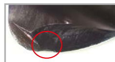
Bozulma nedeni, yüksek yük
