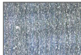
Stan wykończenia powierzchni
